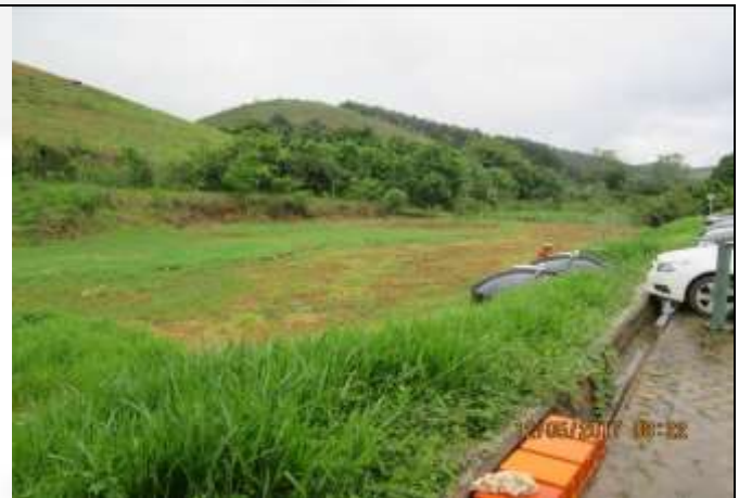
Foto 5: fossa séptica (fossa banho) em APP do córrego Ligação
