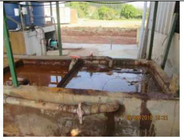
Foto 2: Vista do leito de secagem com o filtro de piscina ao fundo na ETEi
