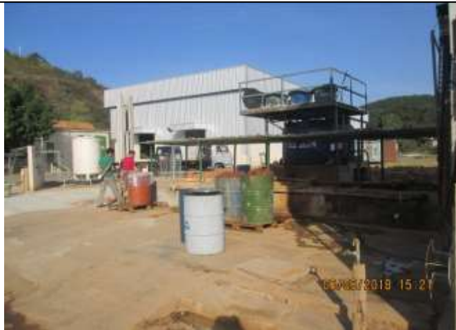
Foto 1: Vista lateral da ETEi com o leito de secagem
